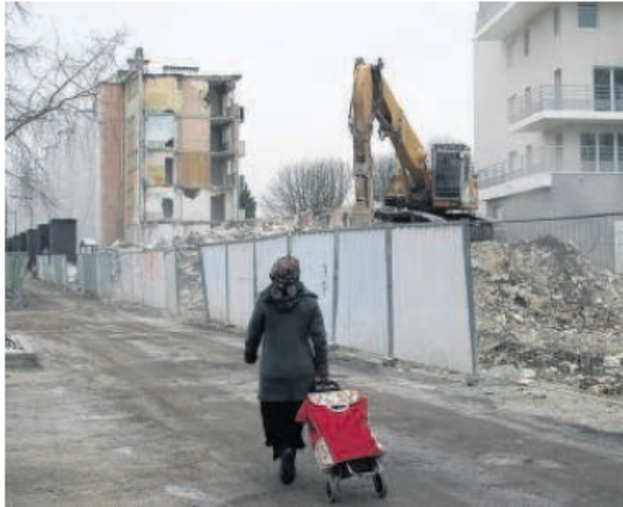
CHELLES, CITÉ DES CRESSONNIÈRES, MERCREDI. Les travaux de déconstruction de l'ancienne barre ont commencé en début de semaine. (LP/C.B.)
